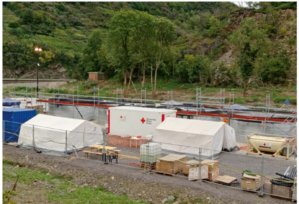
„Kläranlage“: Nahezu die komplette Infrastruktur im Ahrtal ist zerstört. Mit mobilen Kläranlagen werden Übergangslösungen geschaffen, bis die Infrastruktur wieder hergestellt ist.
